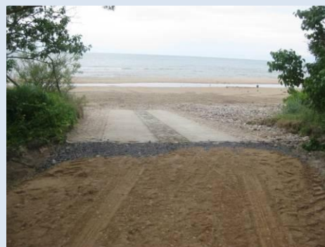
B labiekārtota nobrauktuve uz jūru Pāvilostā Tirgus ielas galā (foto: V. Ģēģere)
