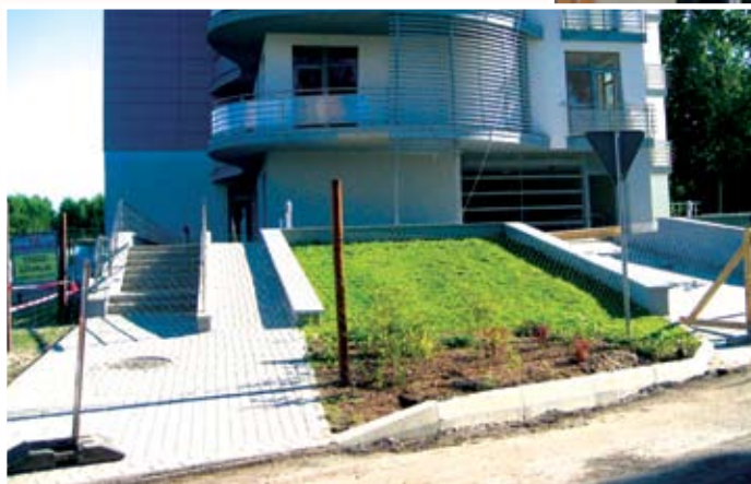
Uzbrauktuves slīpums pārsniedz būvnormatīvos noteikto proporciju 1 : 12 Autors: Māris Dzelzskalns
