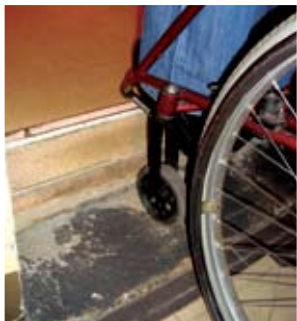
Sliekšņa augstums pārsniedz 15 mm, tāpēc ieeja telpā nav piemērota personai riteņkrēslā Autors: Zane Lasmane
